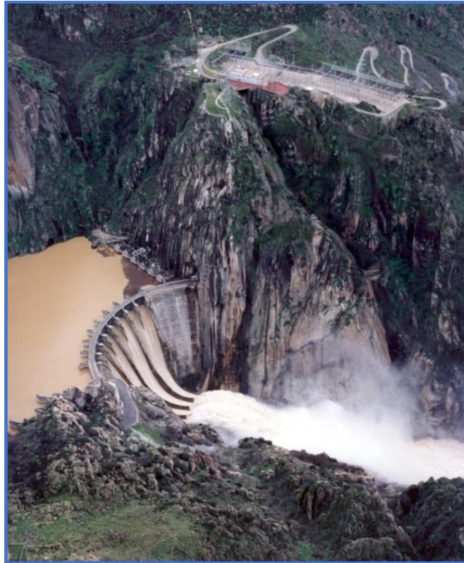
Central hidroeléctrica Aldeadavila. Foto cedida por Iberdrola
