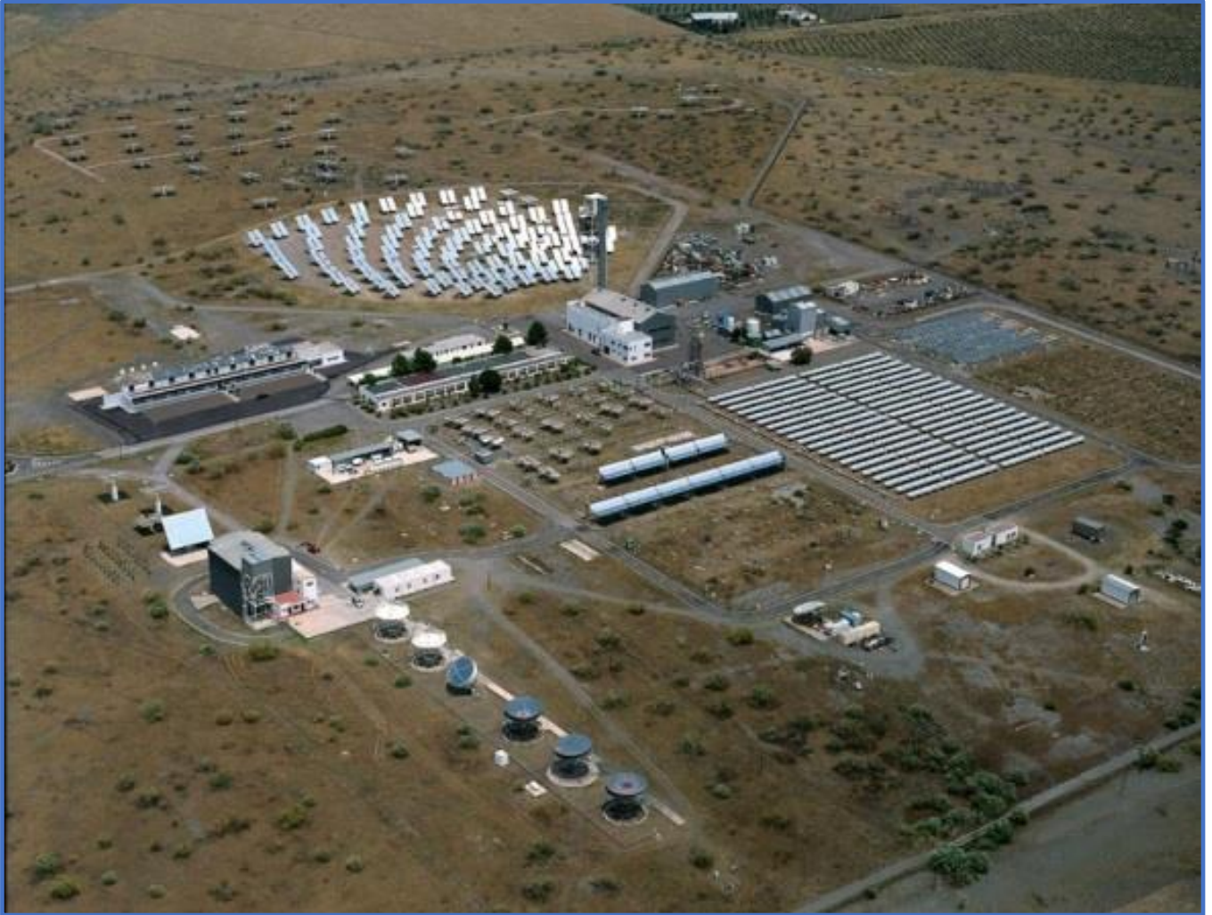
Plataforma Solar de Almería (España)
