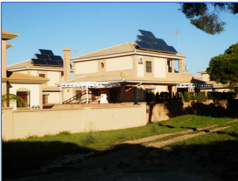
Aplicación de energía solar térmica
