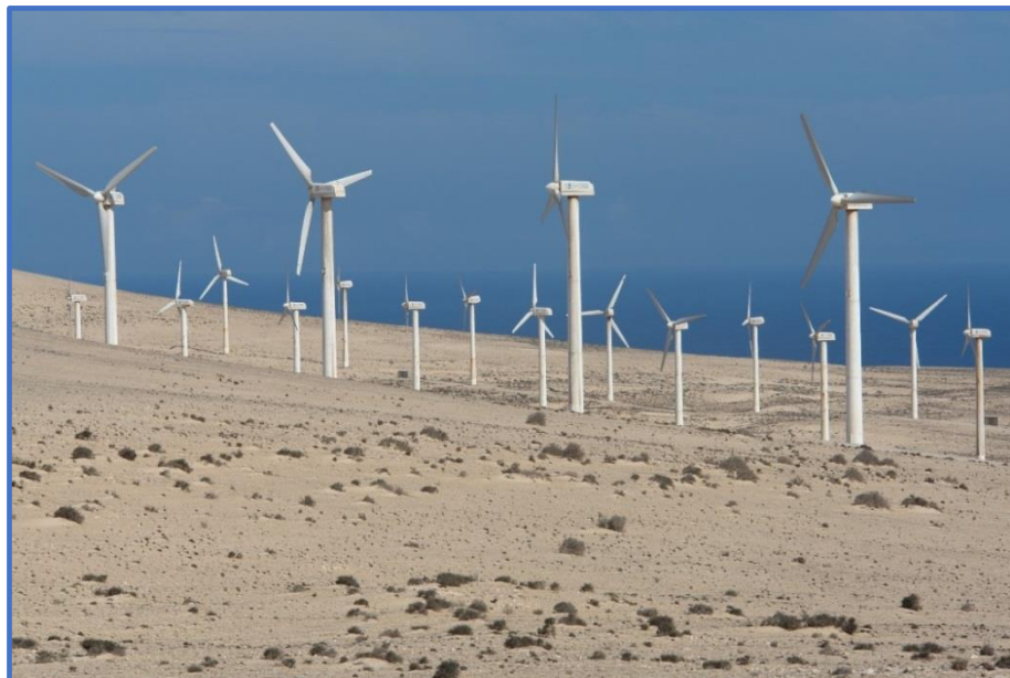
Parque eólico Cañada del Rio. Foto cedida por ENEL GREEN POWER
