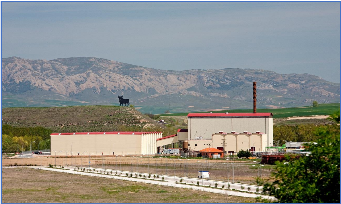
Planta biomasa eléctrica Briviesca. Castilla y León, foto cedida por Acciona
