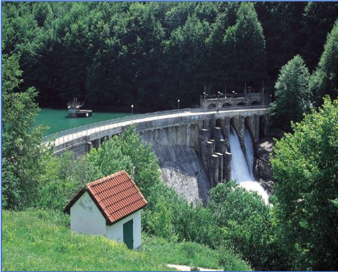
Central hidroeléctrica. Irabia-Navarra. Foto cedida por Acciona
