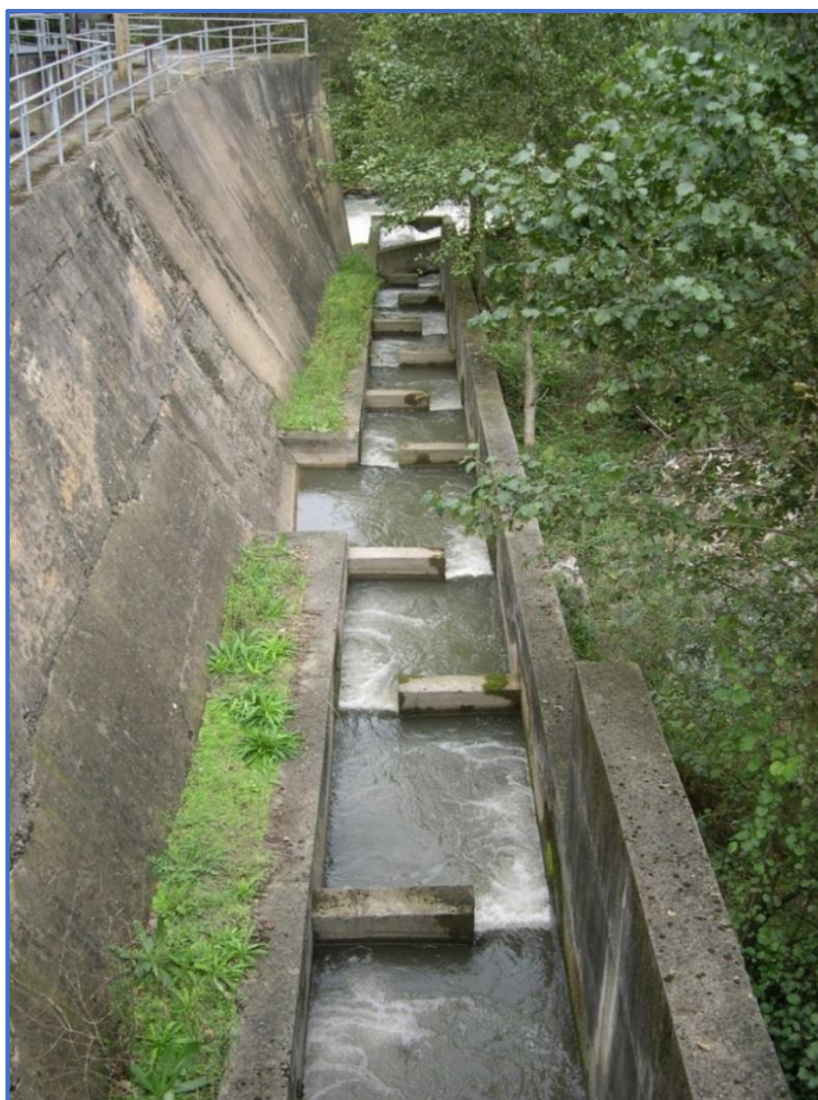
Central mini hidráulica. Escala de peces
