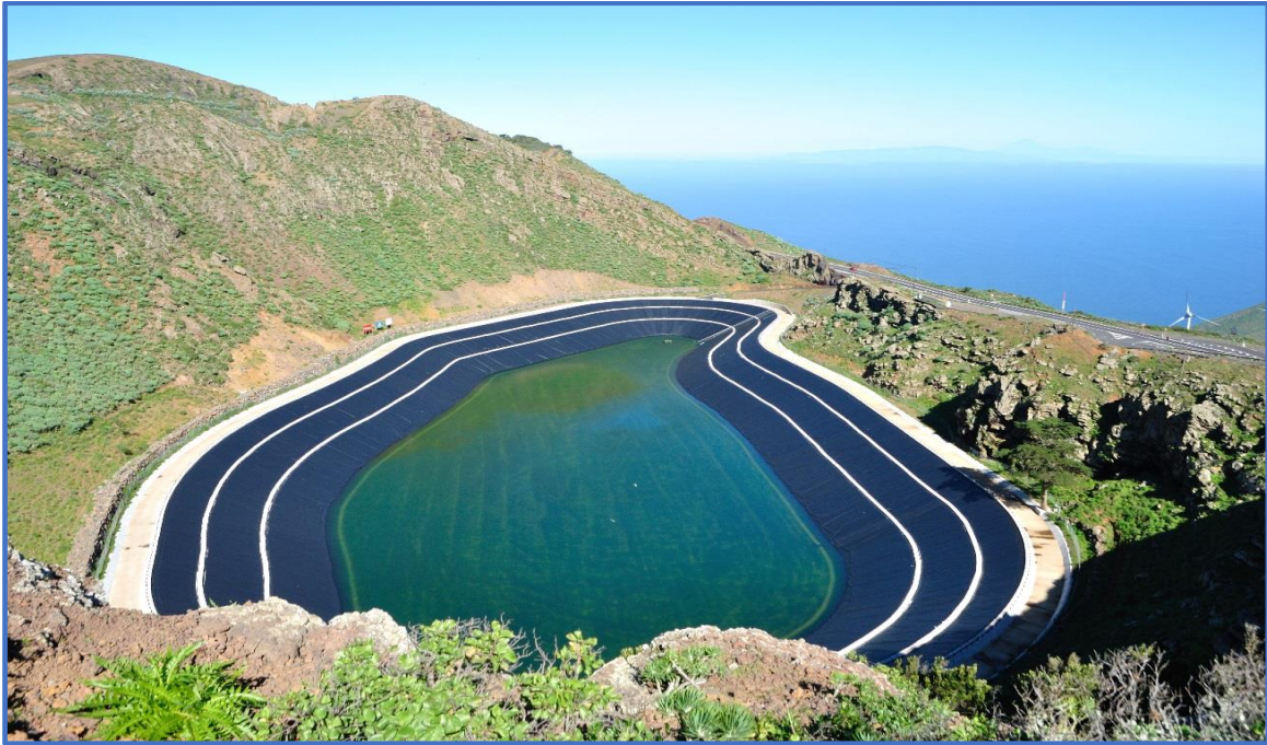
Central Hidroeléctrica Isla de Hierro
