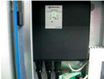
Fig. 59. Equipo receptor de BT
