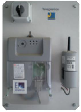
Fig. 15. Concentrador instalado por Endesa en el Proyecto Smartcity Málaga
