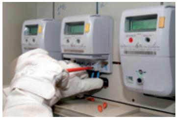
Fig. 13. Detalle de la colocación de contadores por un operario de Endesa en el Proyecto Smartcity Málaga (pág. 36)
