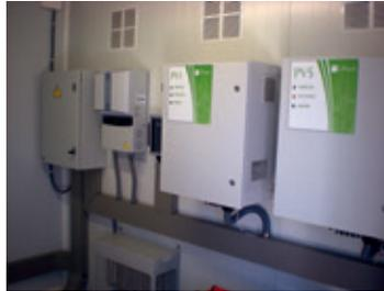
Fig. 32. Instalación de los inversores PV-1 y PV-5
