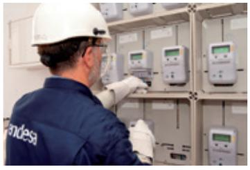
Fig. 14. Colocación de contadores por un operario de Endesa en el Proyecto Smartcity Málaga (pág. 37)
