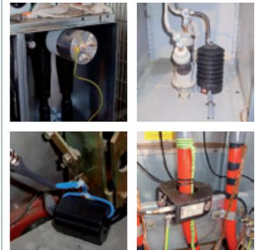
Fig. 42. Ejemplos de sistemas de acoplo para comunicación PLC
