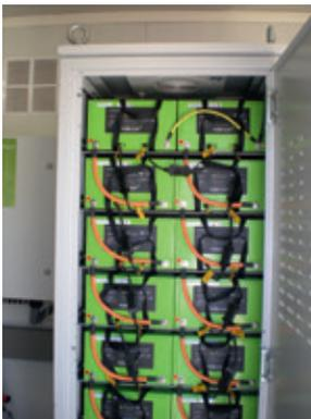
Fig. 34. Imagen del armario instalado y su interior con las baterías de almacenamiento
