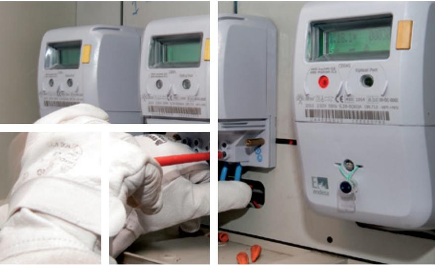
Fig. 13. Detalle de la colocación de contadores por un operario de Endesa en el Proyecto Smartcity Málaga
