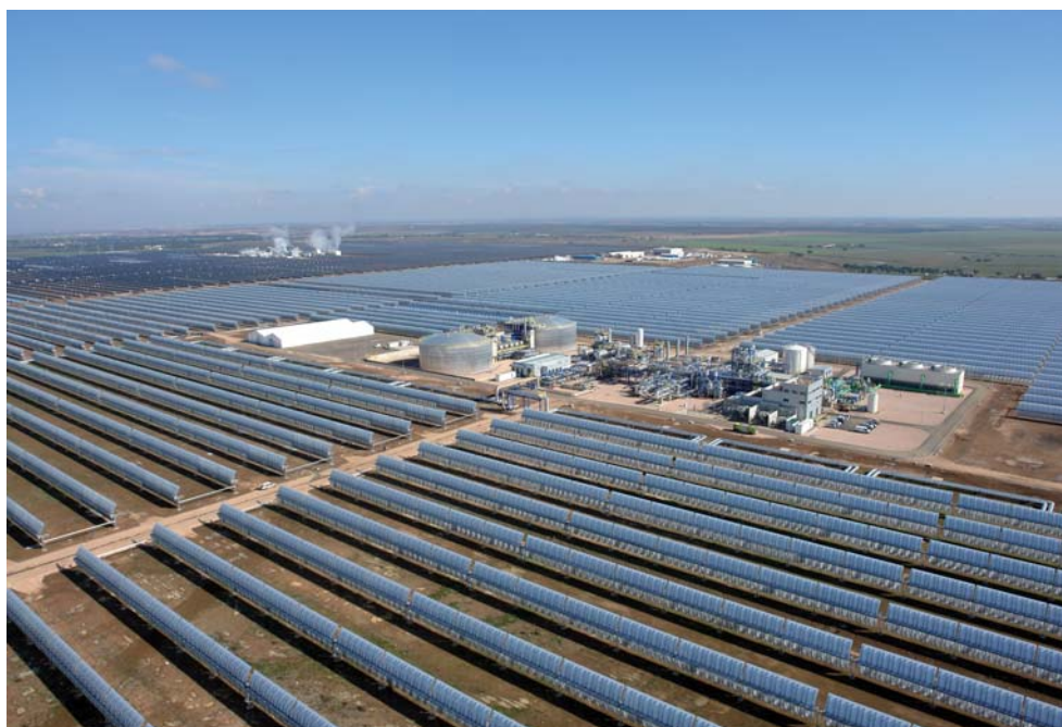
Figura 49. Imagen de un canal parabólico solar en Extresol 1. Propiedad de ACS-Cobra.
