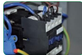
Interruptor de transferencia integrado. Realiza el cambio entre la energía de generador y la procedente de batería de forma totalmente automática.
