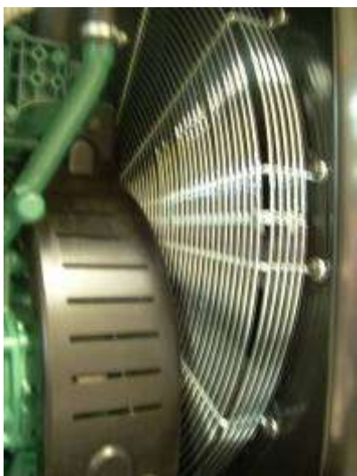
Protección de elementos móviles y calientes
