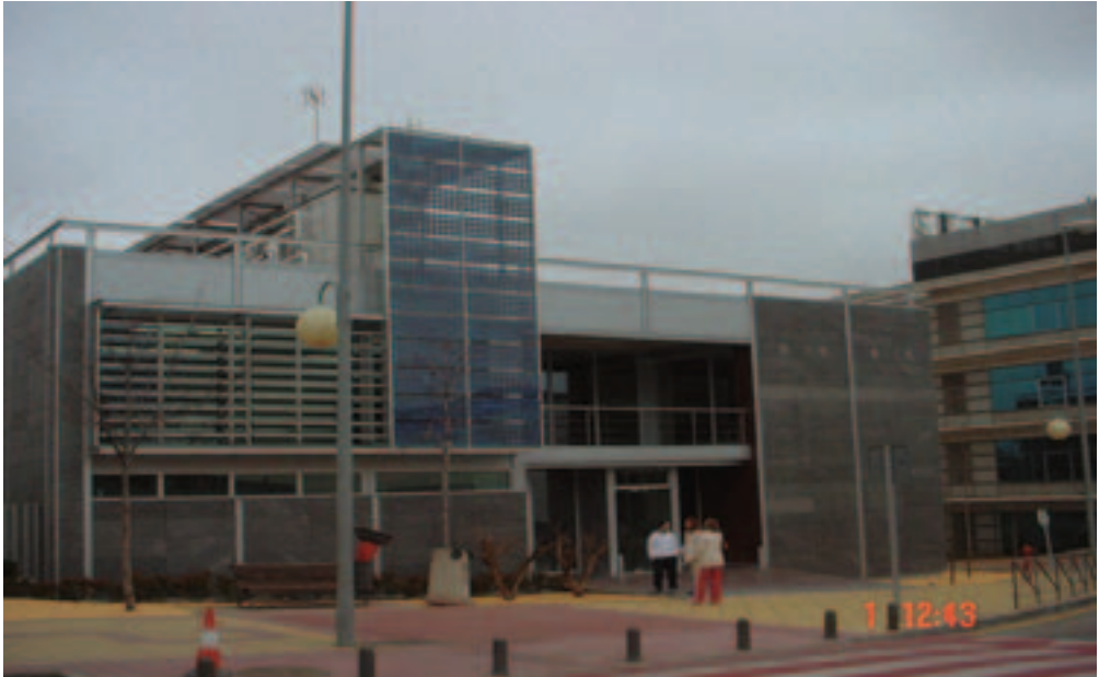
Foto 8. Instalación fotovoltaica integrada en muro cortina.
