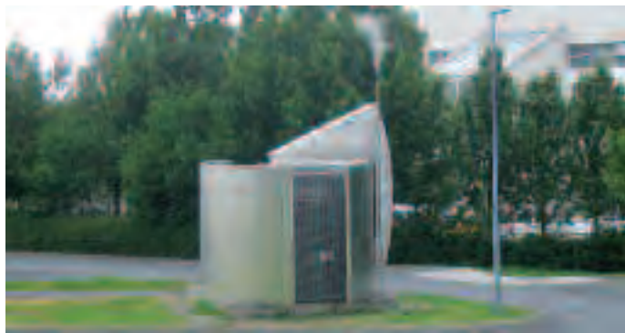
Casetas que cubren las antiguas perforaciones geotérmicas usadas para calefacción en Reykjavik (Islandia), hoy en día interconectadas al sistema general de distribución de calor extendido a toda la ciudad
