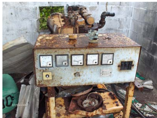
Fig. A.3. Generadores diesel averiados en Playa Chiquita
