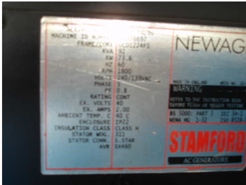
Fig. 23 Placa del Generador Diesel del Comando de Guardacostas – Isla La Iguana
